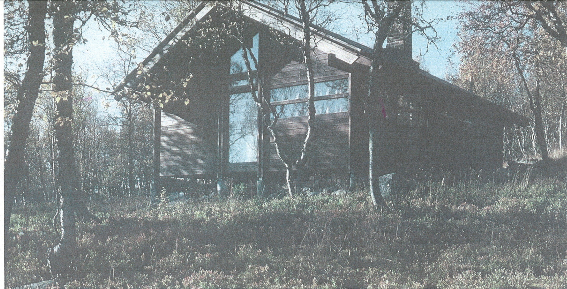
▲ Byggesett: Ål-hytta er basert på en grunnmodul på 80x120. To moduler gir et lite soverom, fire et kjøkken osv. For å gli best mulig inn i terrenget er hytta holdt så lav som mulig.
